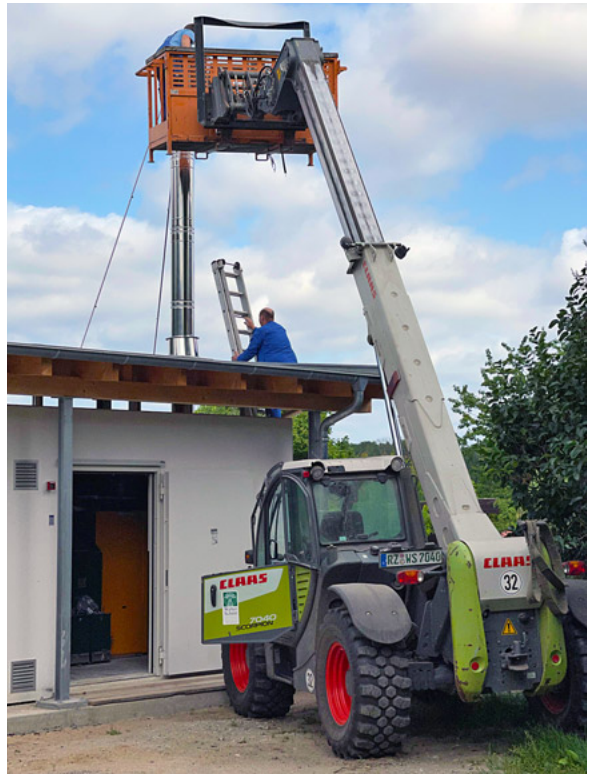
Schornsteinmontage auf dem Heizhaus
